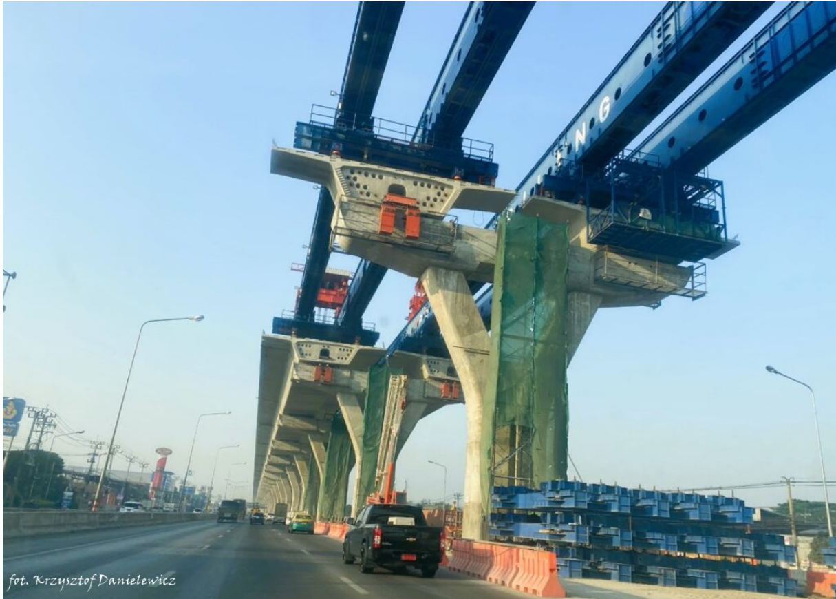
Zdjęcie 15. Budowa drogi szybkiego ruchu na trasie do pływającego targu.
